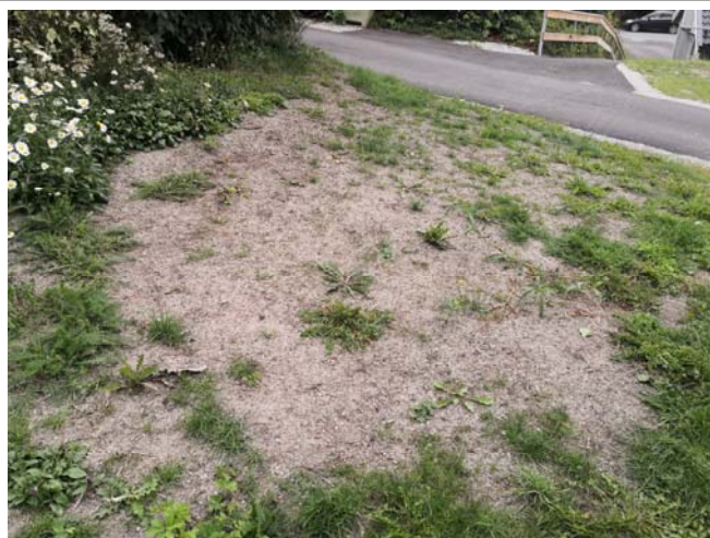
Dette er området mellom bolig 76 og 98. Lite groing
