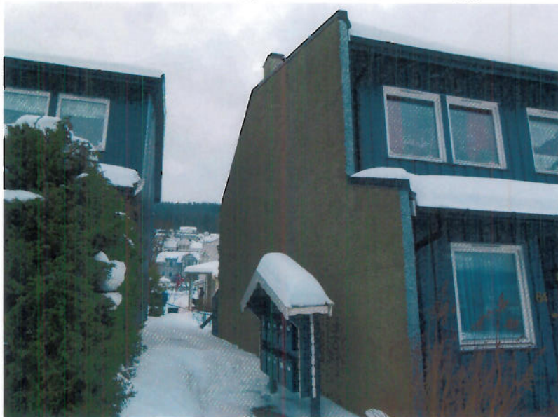
Bilde 3 viser garlvegg som er brannvegg.
